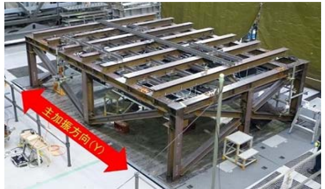
図9. 試験体設置状況
