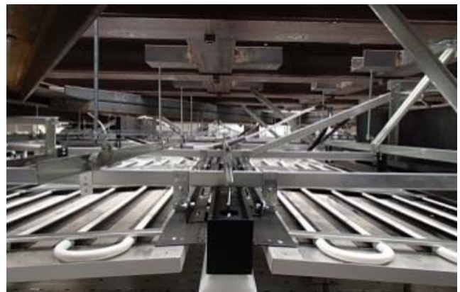
図10. 試験体設置状況（パネル裏）
