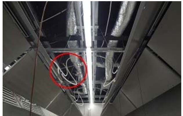
図3. 配管余長設置状況
